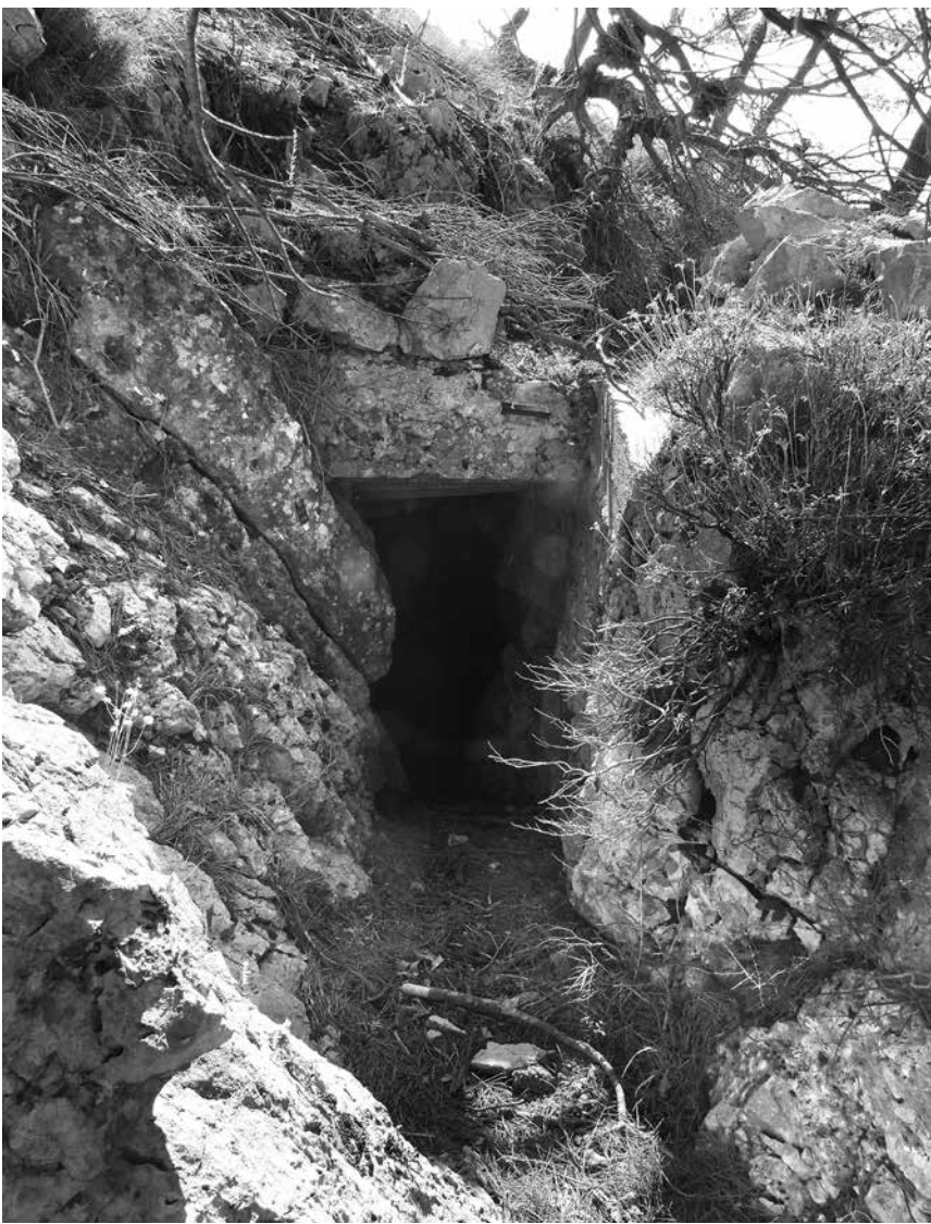
Sl. 12. Pogled na ulaz u bunker
